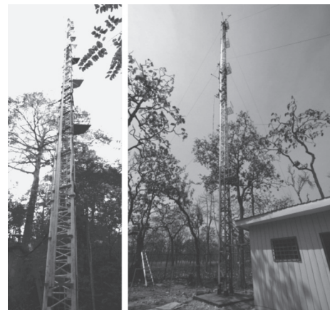
写真 1 常緑林（左：高さ 60 m）と落葉林（右：高さ 30 m）に建てた森林気象観測タワー
