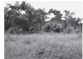
プロジェクトが終了した後、 廃墟化したオフィス 2003
