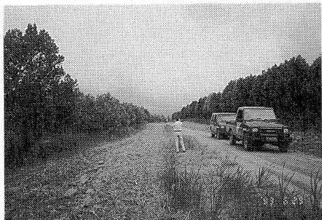
写真-4 南スマトラ州ブナカット地区のバリトー・グループ HTI。マンギウムアカシアの 3 年生造林地。作業道の路肩を拡げて防火帯としている（1993 年 6 月 29 日撮影）
