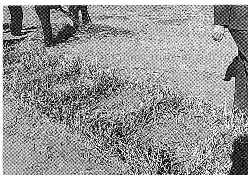
写真-2 施工中の麦藁方格沙障
